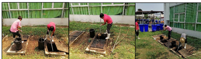
ภาพที่ 3-33 การทำความสะอาดบ่อดักไขมัน ก่อนเข้าระบบบำบัดน้ำเสีย 2
